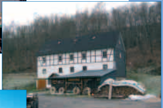
Mühle in Nenkersdorf mit überschlächtigem Wasserrad
