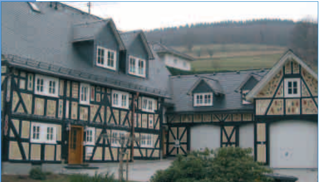
Haus in Nenkersdorf (1779) mit hessisches Kratzputz
