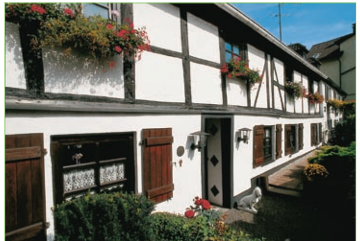
Im Bereich des Spindelsburggrabens und der Vergessenen Straße präsentieren sich heute dank einer behutsam durchgeführten Stadtkernsanierung Fachwerkhäuser aus der Zeit nach 1783 – Foto: Ralf Breer, Hattingen
