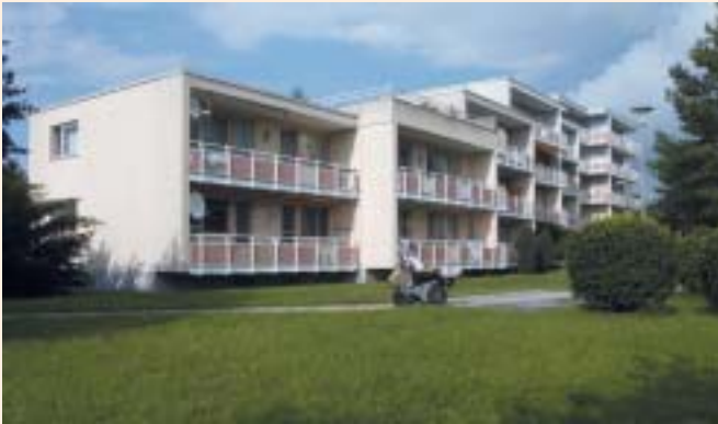
Altenwohnanlage Biebesheim, Haus Rheinblick.
