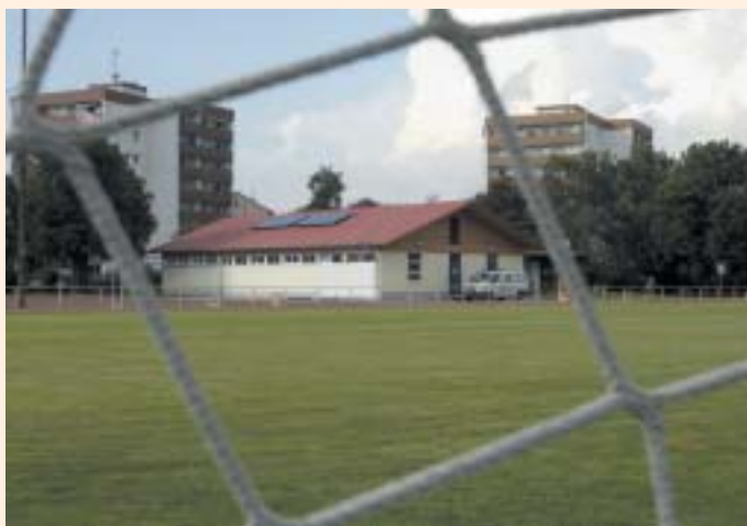
Renoviertes Funktionsgebäude im Rheinstadion.
