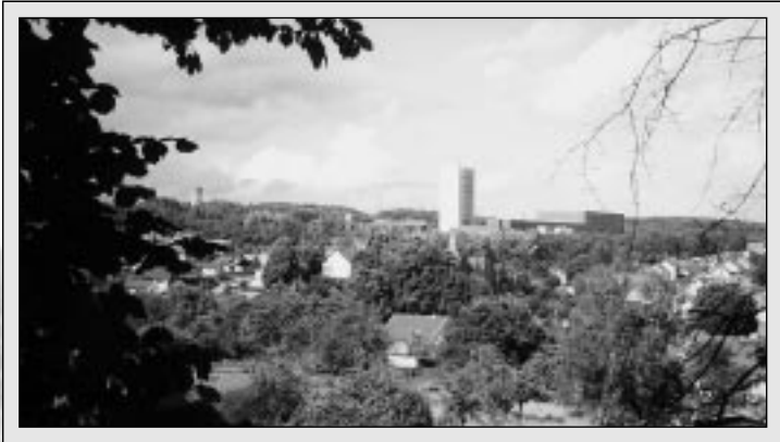
Blick auf Karlsbrunn mit der Warndtschachtanlage
