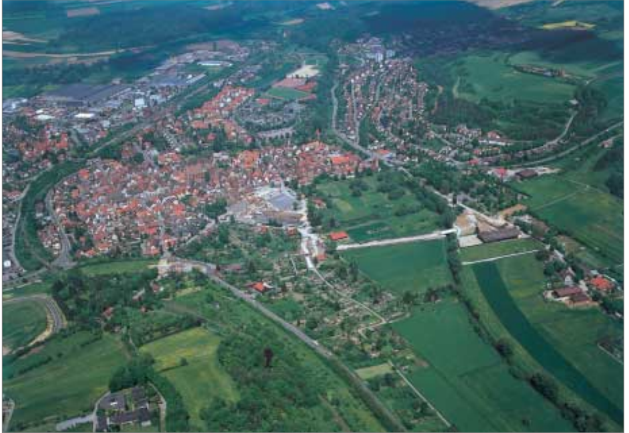
Baumaßnahme Südumfahrung B 295, Stand: 09.05.2000 (Stuttgarter Luftbild Elsässer GmbH)
