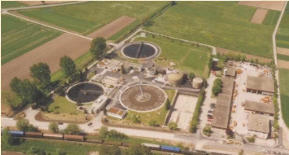
Kläranlage mit Bauhof
