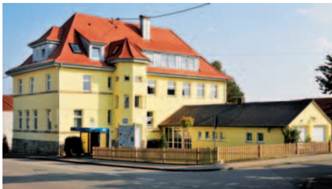
Schulgebäude nach der Sanierung
