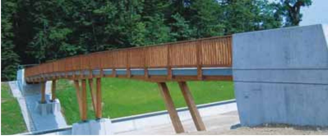
Buchhaldensteg über B 313
