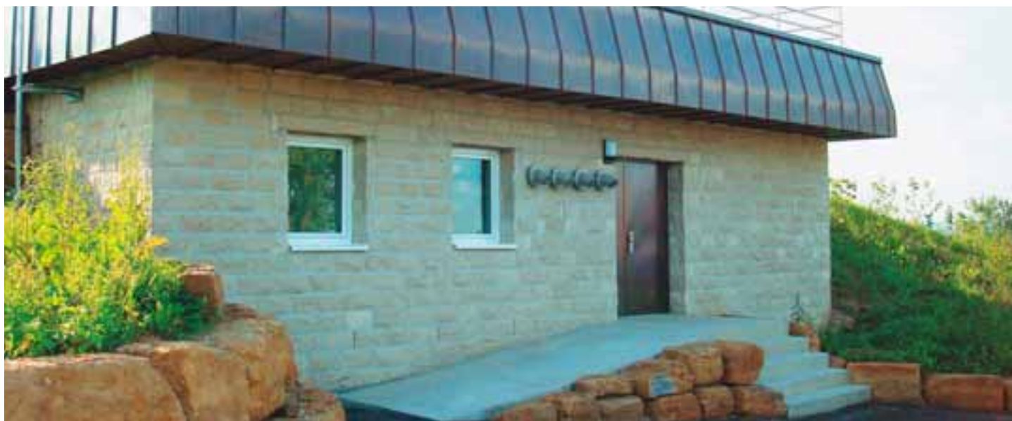
Neuer Wasserhochbehälter auf der Gans
