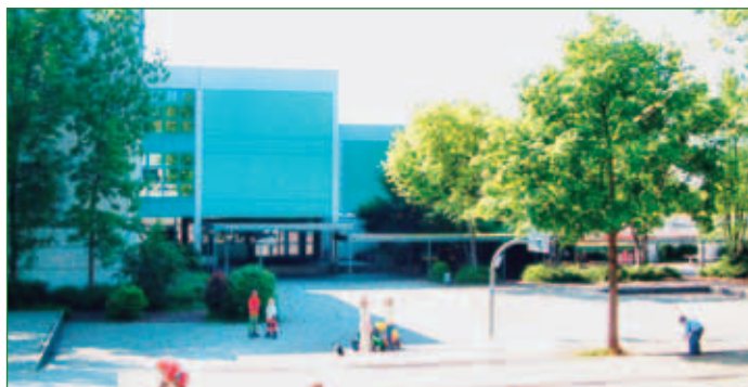
Schulzentrum „Am Berg“.
