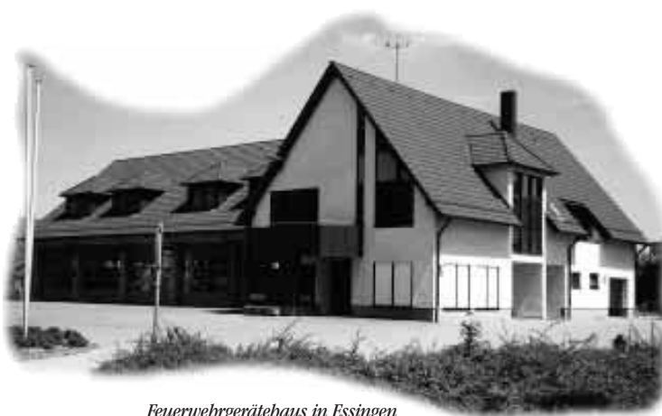
Feuerwebrgerätehaus in Essingen
