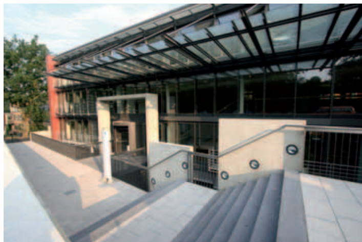
„Haupteingang Haus C“ © Landratsamt Calw
