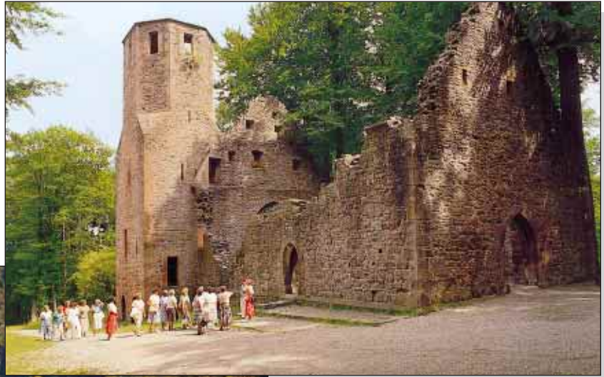
Ruine der St.-Barbara-Kapelle in Karlsbad-Langensteinbach
