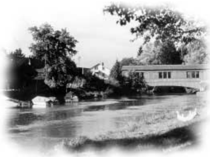
Holzbrücke über die Schussen in Eriskirch
