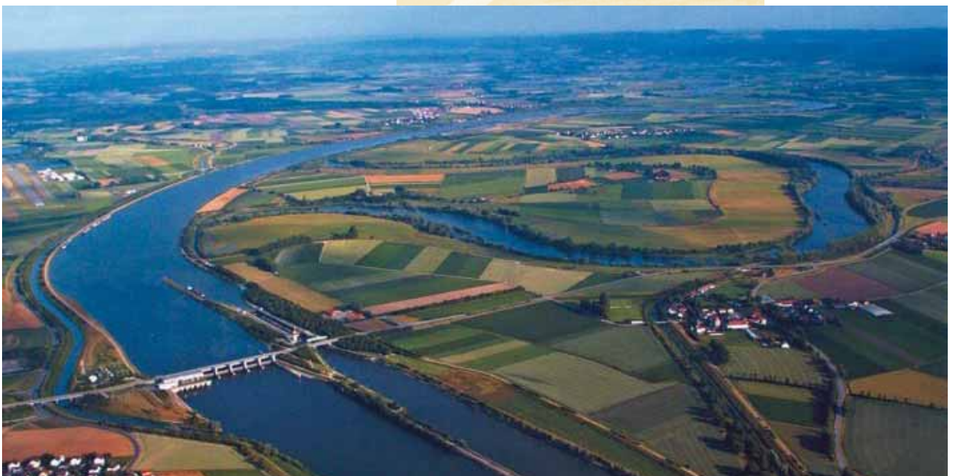
Donauschleife mit Staustufe Bend in the Danube, barrage weir with lock
