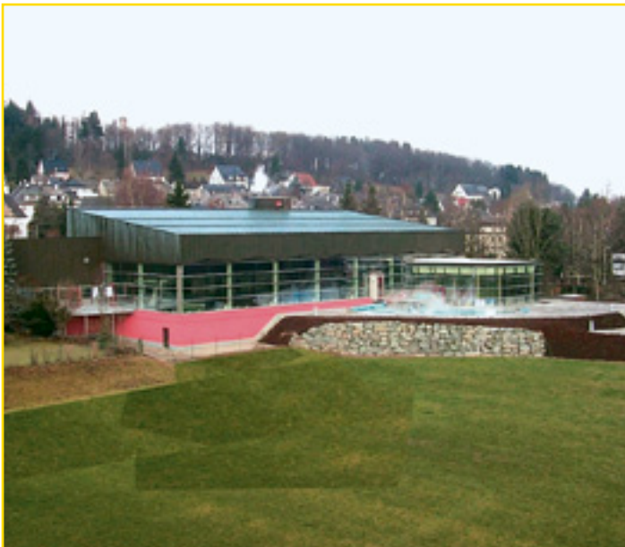
Wellenhallenbad in Helmbrechts
