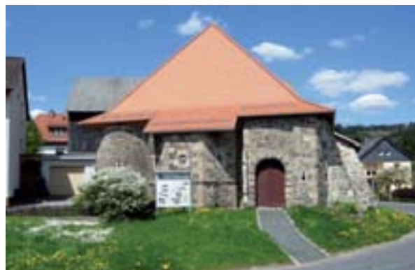
Die Rothenkirchener Burg nach der Dachsanierung.
