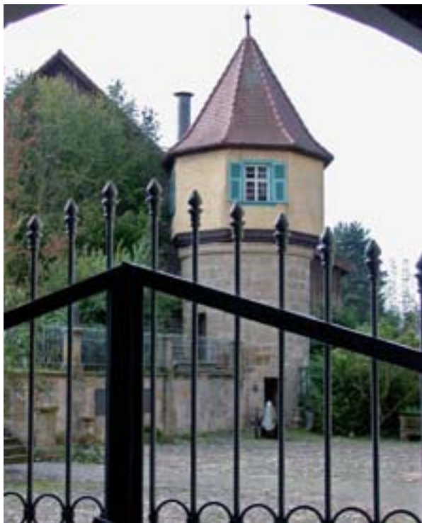
Der Eisturm ist das älteste Gebäude am Neuen Schloss in Küps. Er wurde auch in das Wappen der Marktgemeinde mit aufgenommen.
