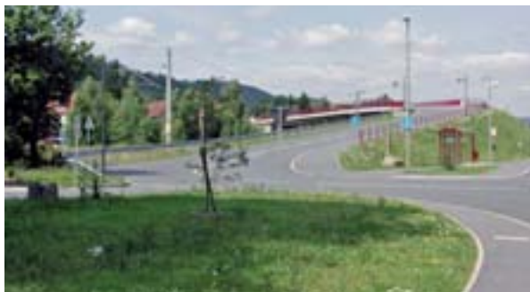
Das „Jahrhundertbauwerk“ Eisenbahnüberführung „Bergwerksstraße“ nördlich des Bahnhofs Stockheim.
