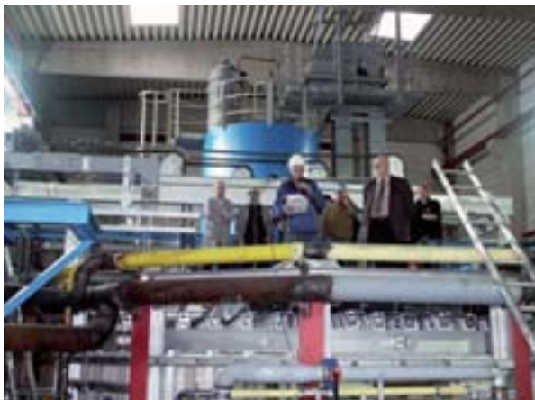
Richtfest für „Wanne 3“ bei Heinz-Glas in Kleintettau: Mit der Investition in die neue Technik entstanden 100 zusätzliche Arbeitsplätze.
