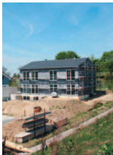
Rohbau mit Außendämmung
