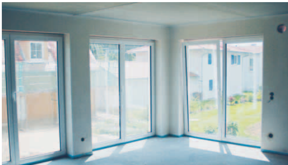
Der Einbau moderner Fenster ist eine Voraussetzung für erfolgreiches Sanieren
