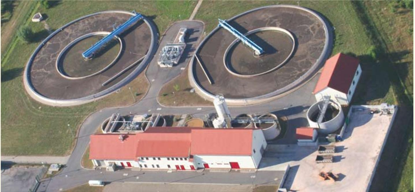
Die Kläranlage Sondershausen verfügt über eine mechanische Reinigungsstufe, eine biologische Reinigungsstufe nach dem Belebtschlammverfahren mit biologischer Entfernung von Kohlenstoff-, Stickstoff- und Phosphorverbindungen sowie die chemische Phosphorentfernung.
